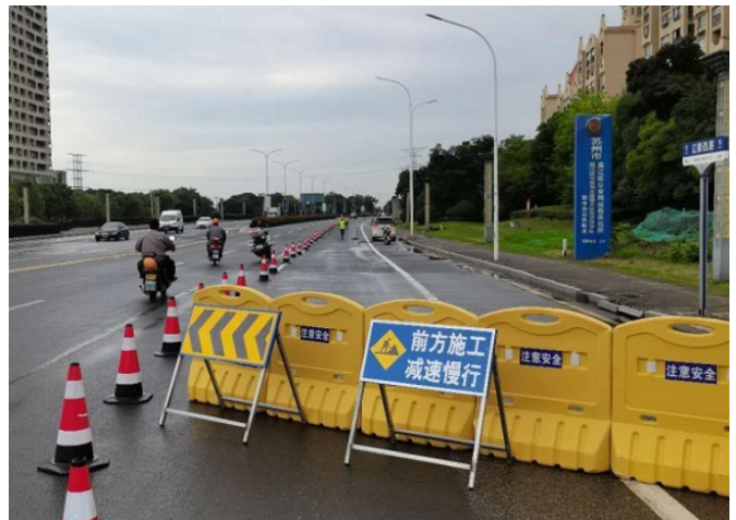
图一：道路施工变道点
