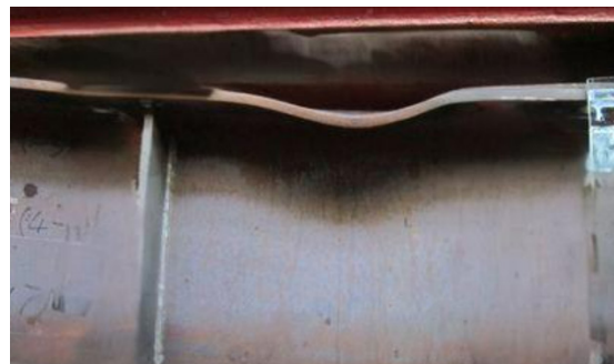
图1 钢梁翼缘局部屈曲
