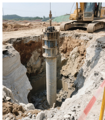
图 1：桩基成孔施工现场示意图
