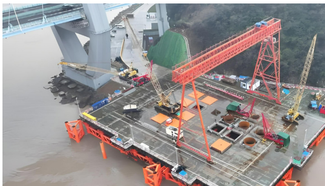
图 2: 桥梁钻孔灌注桩施工
