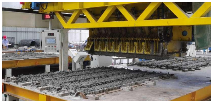
图1 预制混凝土构件生产环节
