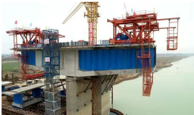
图1 大跨度波形钢腹板连续箱梁结构
