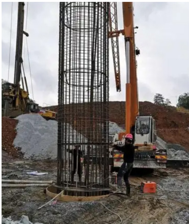
图 1 钢筋笼安装
