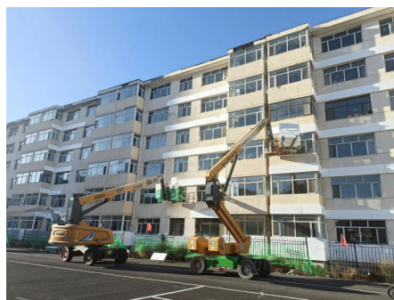
图1 老旧建筑暖通改造高空作业
