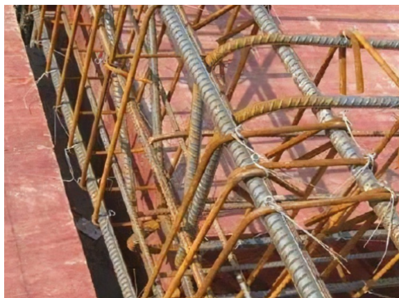
图一：墙体钢筋绑扎做法标准
