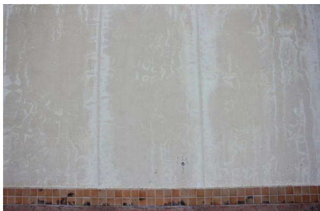
图 2 某项目整改后墙面效果
