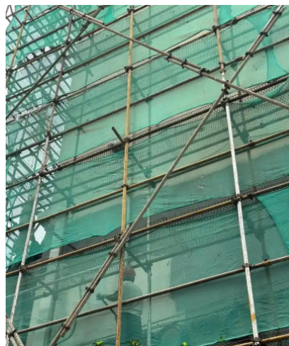
图2 高层建筑主体结构施工现场
