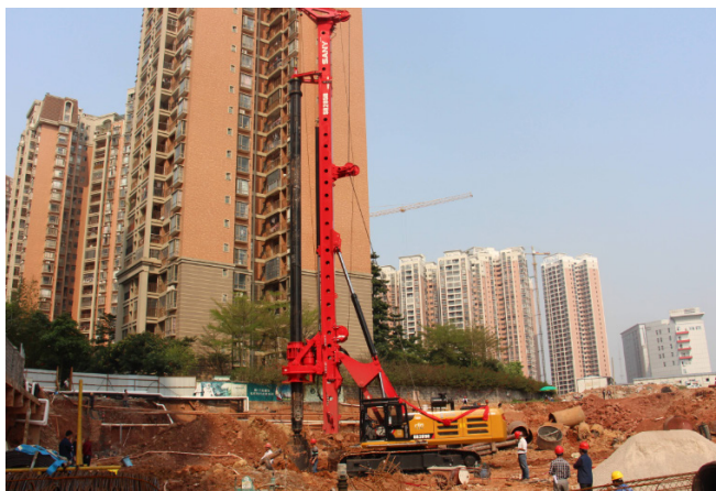
图1 某高层建筑基础施工现场
