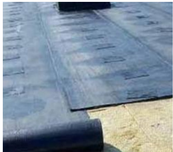
图1 防水卷材铺贴及搭接
