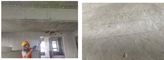
图 1 基层处理与弹线、定位
