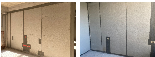
图2 自检与清理施工现场
