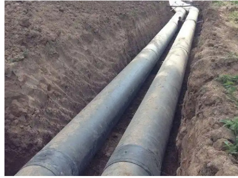
图1 地埋式管道敷设
