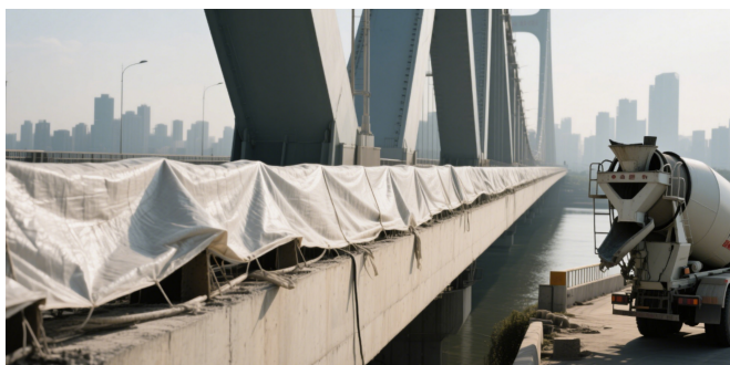
图 1 混凝土覆盖养护布
