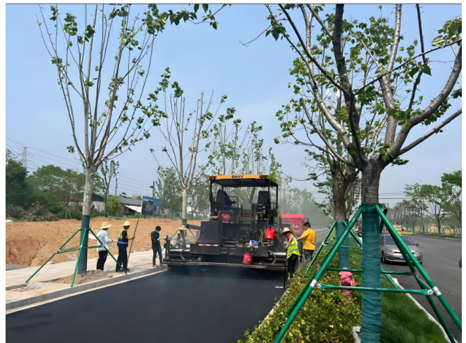
图一 市政道路施工现场图
