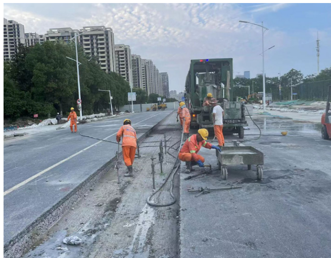
图二 道路注浆加固
