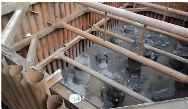
图3 微型钢管桩支护示例图
