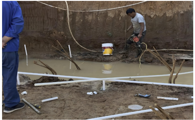
图 2 降水系统施工示例图
