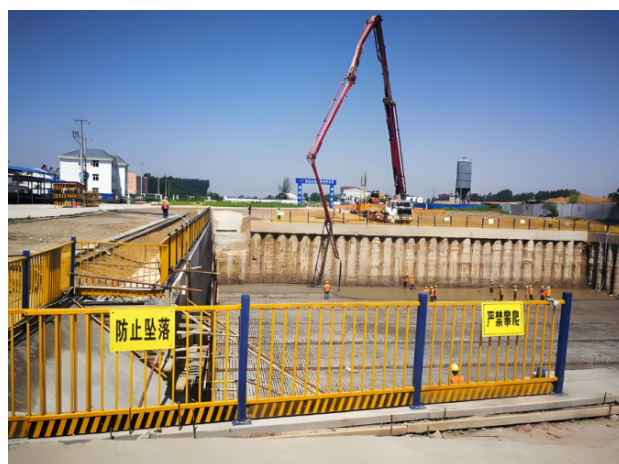
图1 基坑围护结构施工示例图
