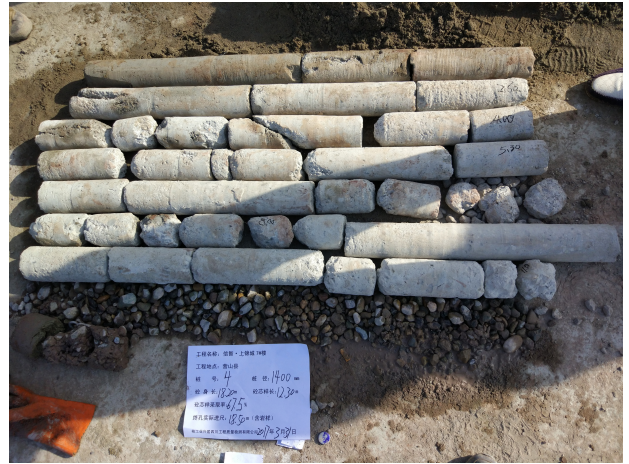
图4 4#桩混凝土芯样图
