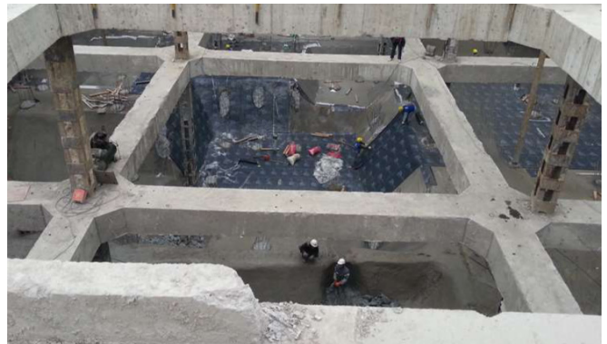
图1 深基坑防水施工
