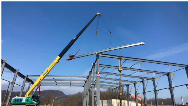
图1 钢构件吊装作业
