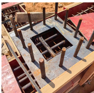
图1 柱筋定位钢板安装
