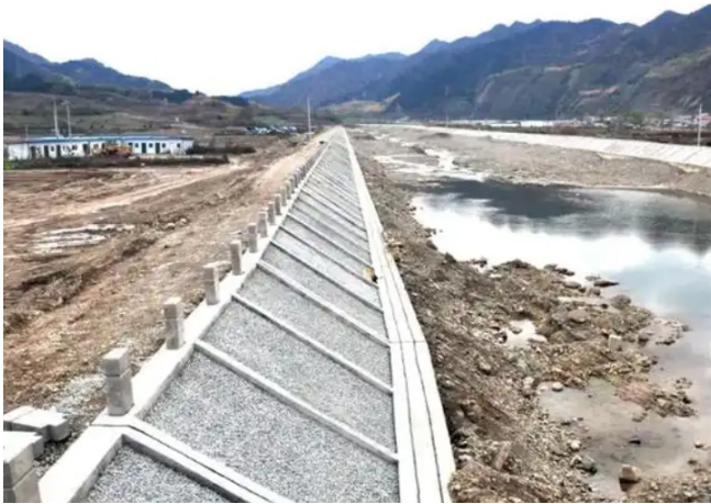
图 1：堤防工程水土保持
