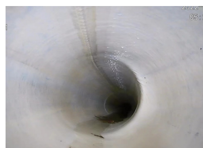
图 4 支连管修复后的管内情况
