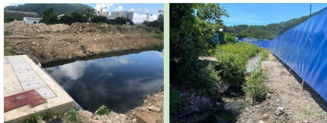
图2：南涌起点污染情况(左)和方圆地产施工废水直排情况(右)
