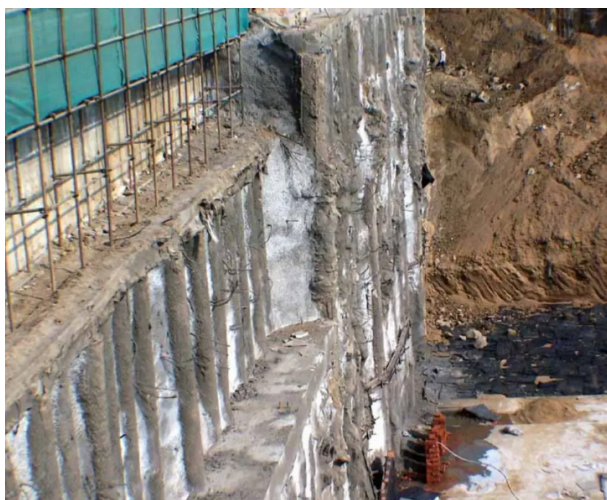
图1 基坑的交错相间排桩支护
