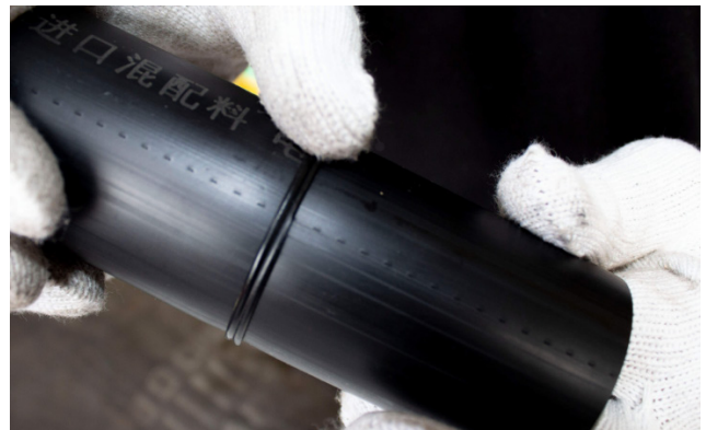
图一：HDPE 管焊接
