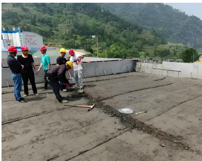
图1 分缝分块施工
