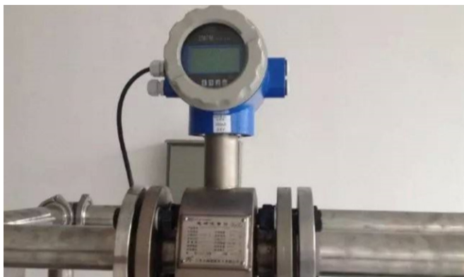
图 1 压力传感器与流量监测设备
