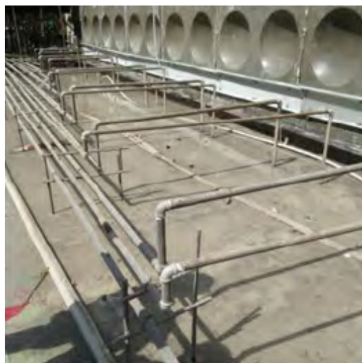
图1 水库坝基灌浆预埋管现场安装实例
