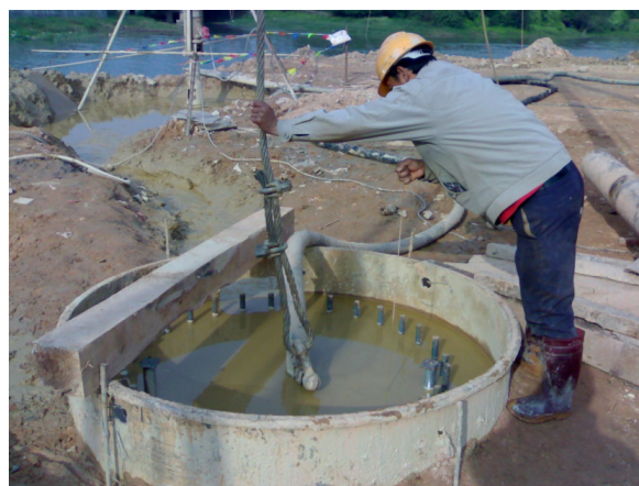
图1 桩底沉渣厚度测量
