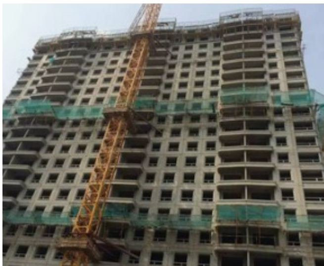
图四 主体工程施工
