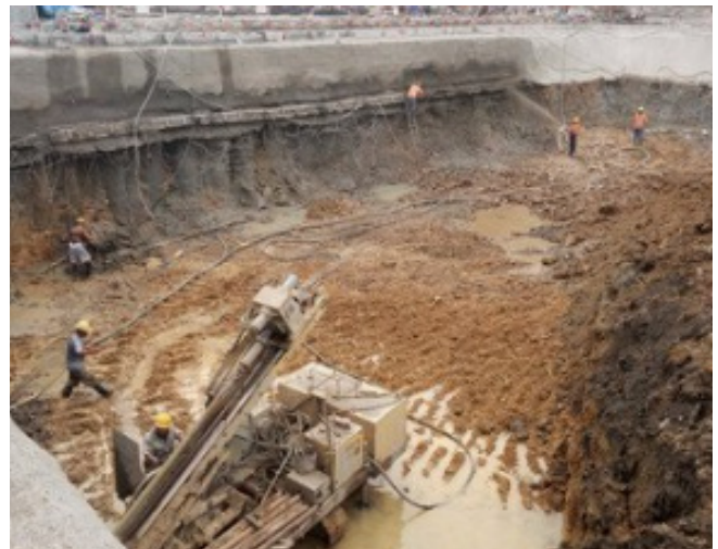
图三 基坑工程
