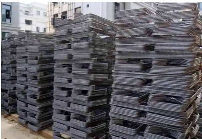
图1 施工材料标准化管理
