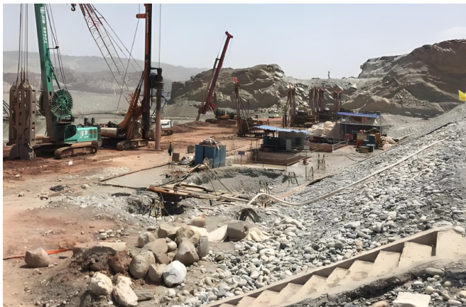
图3 混合型防渗墙施工图
