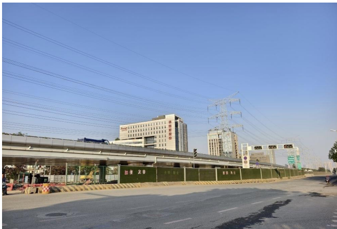
图 2 亚运大道前锋路节点改造工程
