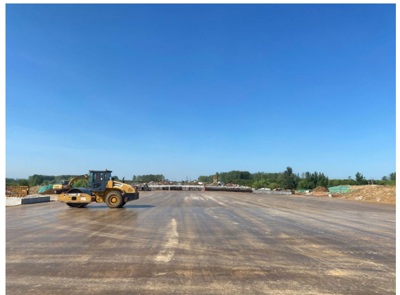
魏武路软土路基段灰土填筑碾压成型照片
