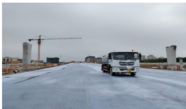
引桥段水稳路基养护照片
