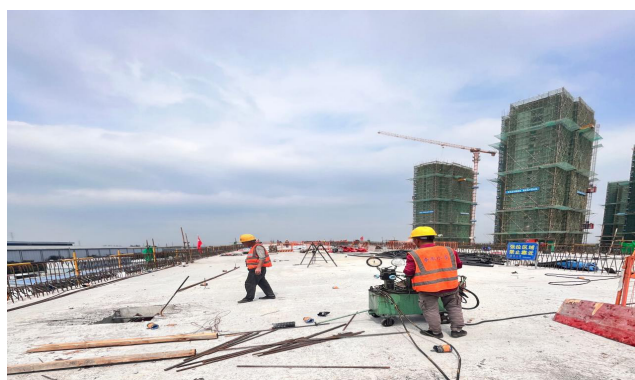
合肥市魏武路项目桥梁预应力施工现场照片
