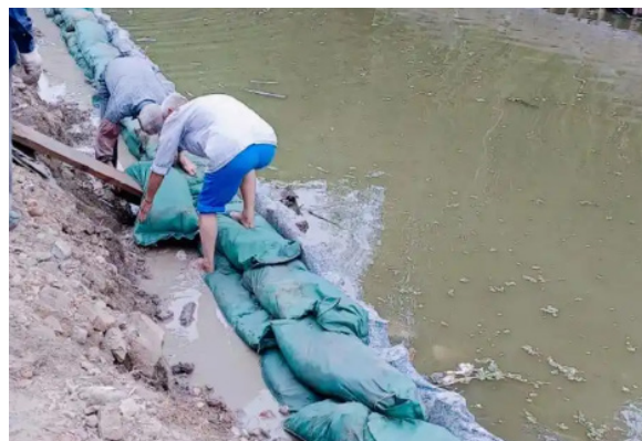
图1 河道治理护坡固土绿化用生态袋
