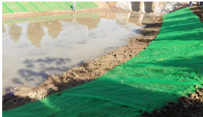
图2 三维植被网河道治理山体护坡加固
