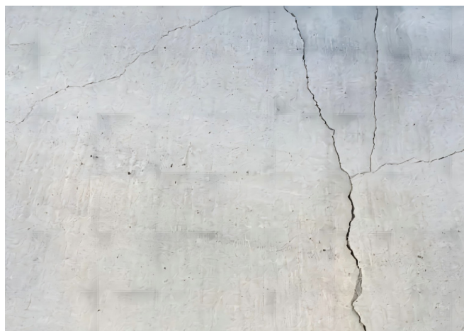
图1：混凝土裂缝
