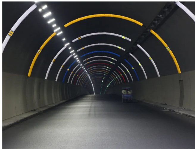
图2 线隧道LED配光及彩色反光环诱导
