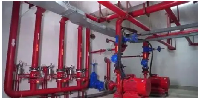
图1 建筑工程消防水系统安装项目
