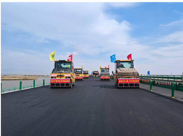
图1 压路机施工图
