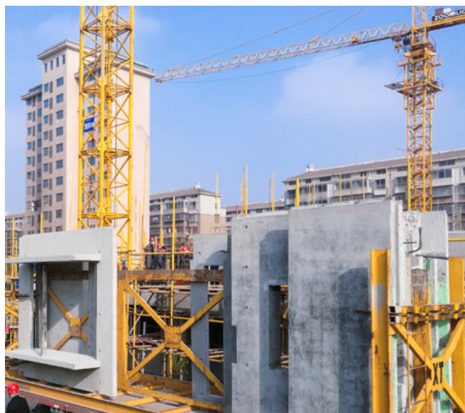
图 1：模块化、高效安装的现场施工
