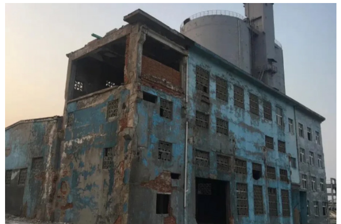
图2 某旧城改造既有建筑物
