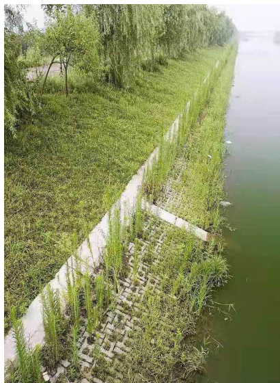
图1 鱼巢砖生态护坡
