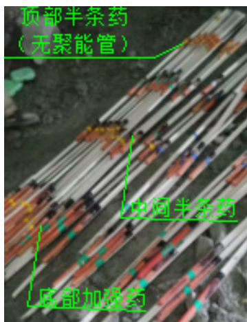
图 4 周边光面孔装药示意图
