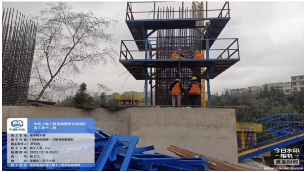
图 2-2 钢筋定位+一体防护平台工装
