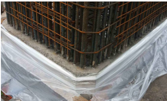
图 2-3 止浆围裙现场施工图
