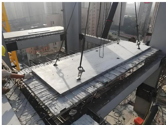
图1 某小区楼板吊装
