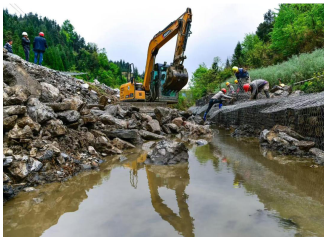
图2 施工现场质量管控监理场景图
