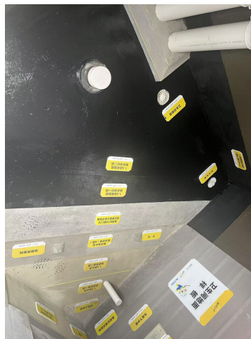
图1：卫生间地面的做法样板
