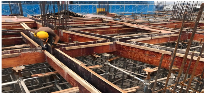
图1 混凝土梁模板安装现场
