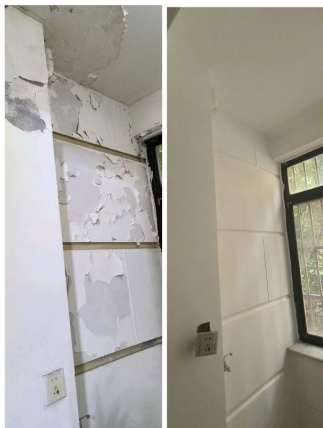
图3 墙面质量问题整改对比图
