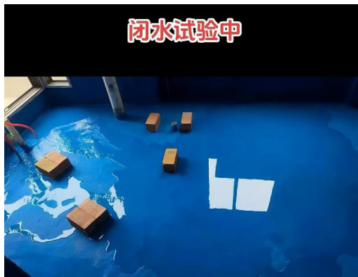
图1 闭水试验过程现场图
