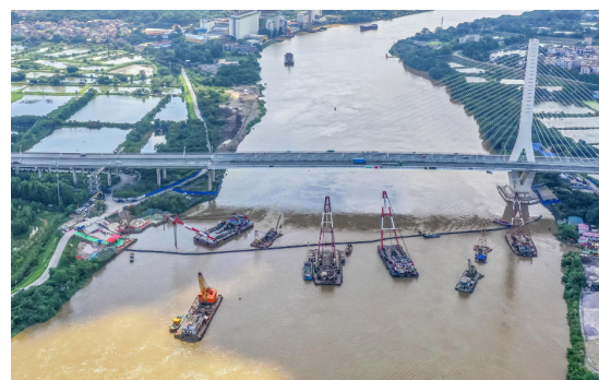
给水管道沉管施工现场
